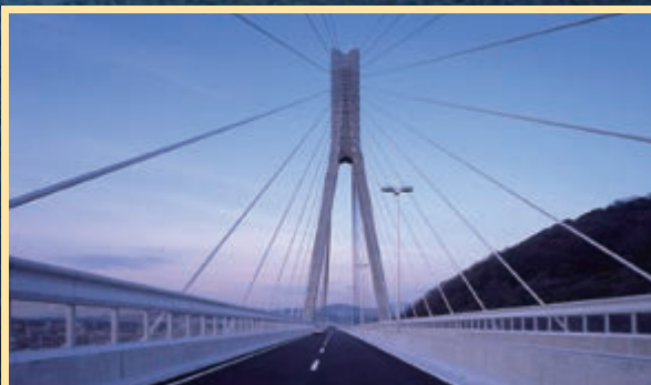
コンクリート斜張橋
