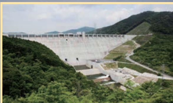
重力式コンクリートダム
