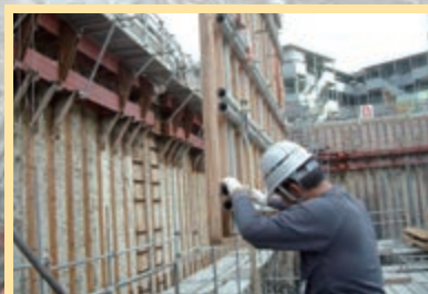
外壁地組組立
