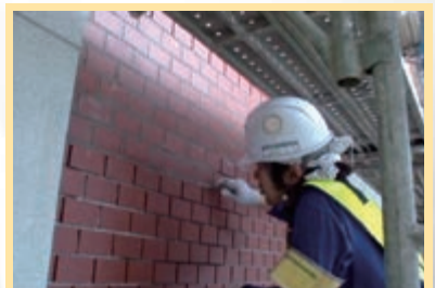
駅 装飾壁の仕上げ
