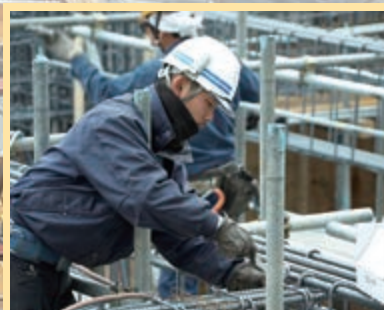
工事現場で鉄筋組立を行う。
