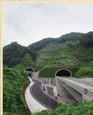
新東名高速道路 トンネル
